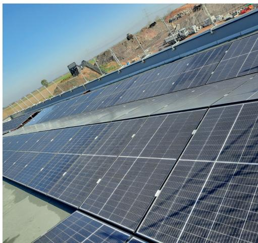
Pose de panneaux photovoltaïques chantier Eurovia, GALLIM Energies. Toiture sécurisée par garde-corps et filets.
