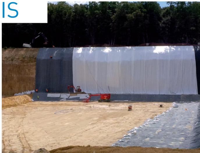
d'une nacelle pour positionner le PEHD et effectuer les soudures sur le mur vertical.
