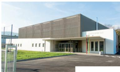
Il s'agit de la construction d'une nouvelle salle de gymnastique spécialisée. La toiture de la grande salle de 1 300 m<sup>2</sup> est composée d'un bac acier acoustique isolé de 240 mm, d'association laine de roche/polystyrène avec
