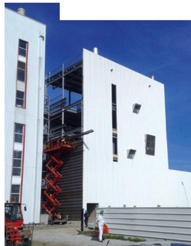
Une tour de 24 mètres de haut, 1 400 m<sup>2</sup> de bardage double peau, 400 m<sup>2</sup> de panneaux sandwich et 750 m<sup>2</sup> de couverture pour une unité de séchage des écorces pour le compte d'un grand groupe dans le domaine de l'alimentaire, situé à Strasbourg au port du Rhin. Voici le défi qui a été relevé il y a à peine plus de trois mois, pour un démarrage de la production début décembre.
