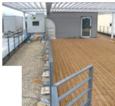
Ce ne sont pas moins de 1692m<sup>2</sup> d'étanchéité sous gravillons - 579m<sup>2</sup> sous platelage bois - 332m<sup>2</sup> en auto protégé - 790m<sup>2</sup> de jardins sous tapis précultivés - 330m<sup>2</sup> de bardage - 1500ml de relevés isolés et couvertines cachant les relevés alu. Equipe principale : Boubertakh-Skou, conducteur des travaux : Eric DALMATA
