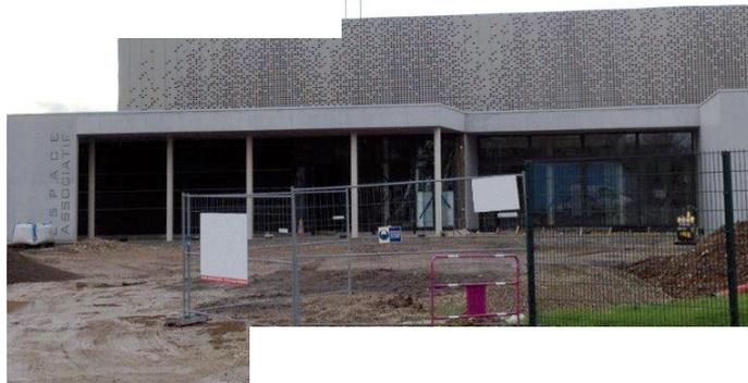
au préalable sont combinées et permettent d'obtenir un dégradé. De plus, le bardage est filant devant les châssis afin de réaliser un contrôle solaire dans le bâtiment, tout en masquant visuellement ces derniers depuis l'extérieur.
