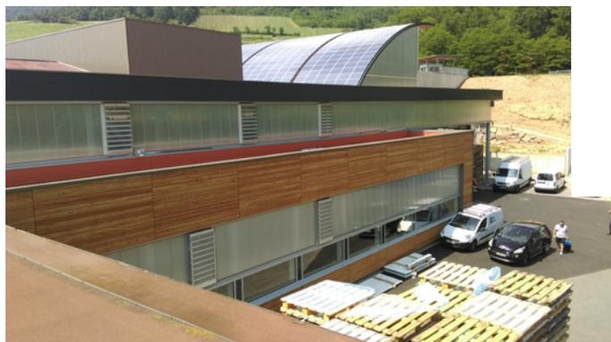
avec étanchéité PVC revêtue d'une membrane Mo (coupe-feu) entoure la toiture principale. Le délai des travaux a été raccourci au maximum (5 mois) afin de ne pas pénaliser l'activité de la cave.
