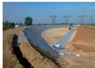
EGC GALOPIN met en œuvre sur l'aéroport de ROISSY CHARLES-DE-GAULLE, pour le compte d'AÉROPORT de PARIS, un dispositif d'étanchéité par géomembrane bitumineuse d'une surface de 17 000 m<sup>2</sup>, dans un bassin de stockage des eaux en cas de débordement de
